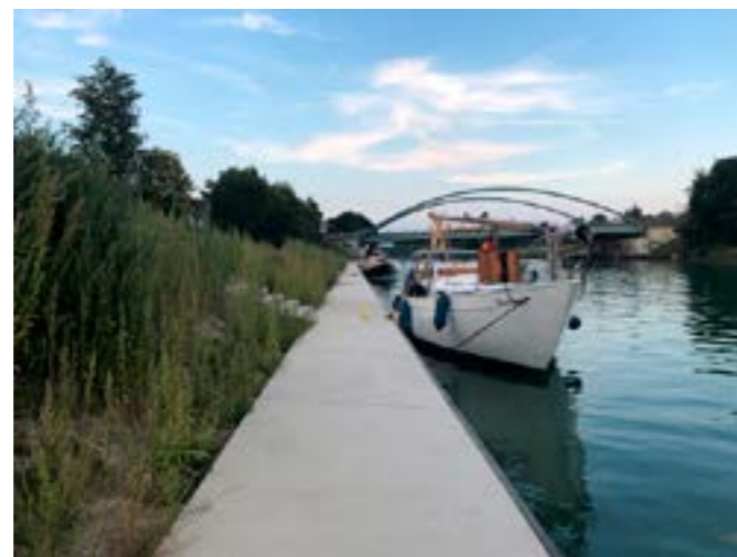
In Senden liggen we aan een kade die nog in aanbouw is.
