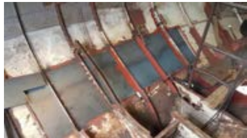
De montage van nieuw plaatwerk.
