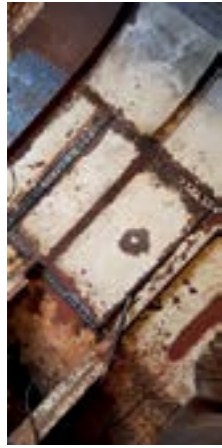
Gedelamineerd plaatwerk.
