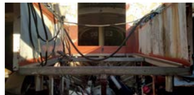
Vorbereiding nieuwe kuipvloer.
