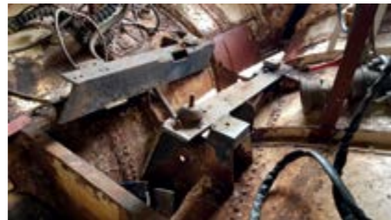
Delen van de motorfundatie zijn verwijderd
