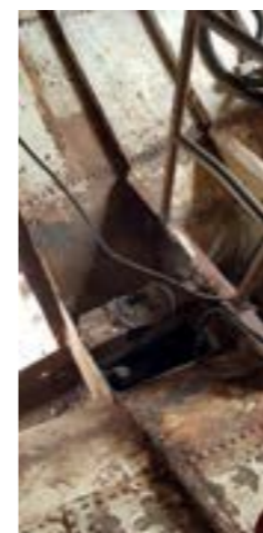
De mastfundatie is verwijderd. Tijdelijk is een oude trap geplaatst om het verband in de romp te houden.
