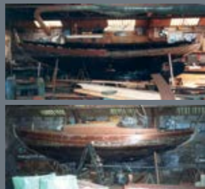
Boven: De Narwal, nog met de oude opbouw, maar met nieuwe stevens. Onder: De nieuwe opbouw op de Narwal.
