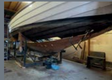
De laatste originele gangen van de Narwal worden vervangen.
