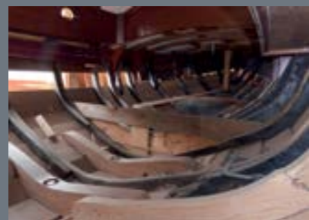
De constructie van de Narwal, met nieuwe wrangen en spanten. Waar de oude spanten nog goed waren zijn ze gehandhaafd en zijn er zusterspanten naast geplaatst.
