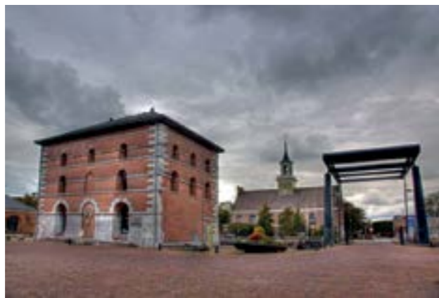
Rijkswerf Willemsoord, Den Helder, pompgebouw droogdok.
