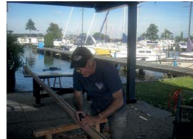
Op dikke schaven van de mast
