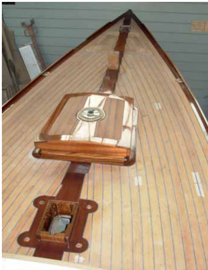
Nieuw dek gelegd
