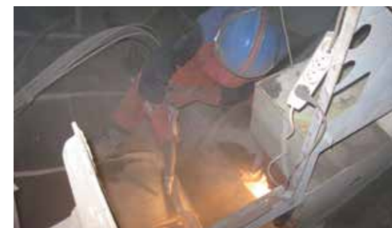
ZANDSTRALEN BINNENKANT ROMP
