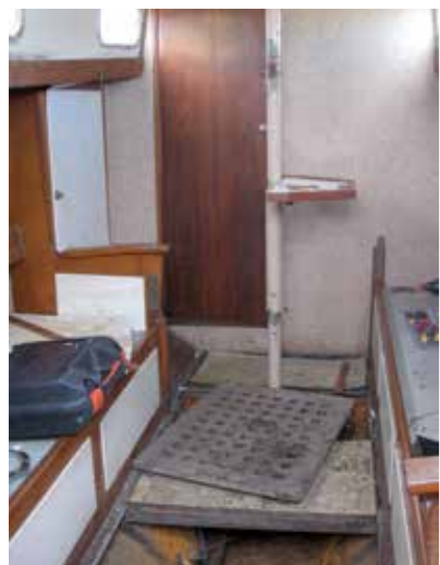
HET INTERIEUR WERD VERWIJDERD OM DE BINNENKANT VAN DE ROMP TE ONTROESTEN EN TE SCHILDEREN
