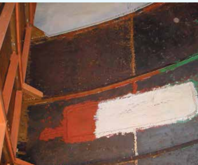
EEN STUK PLAAT INGELAST
