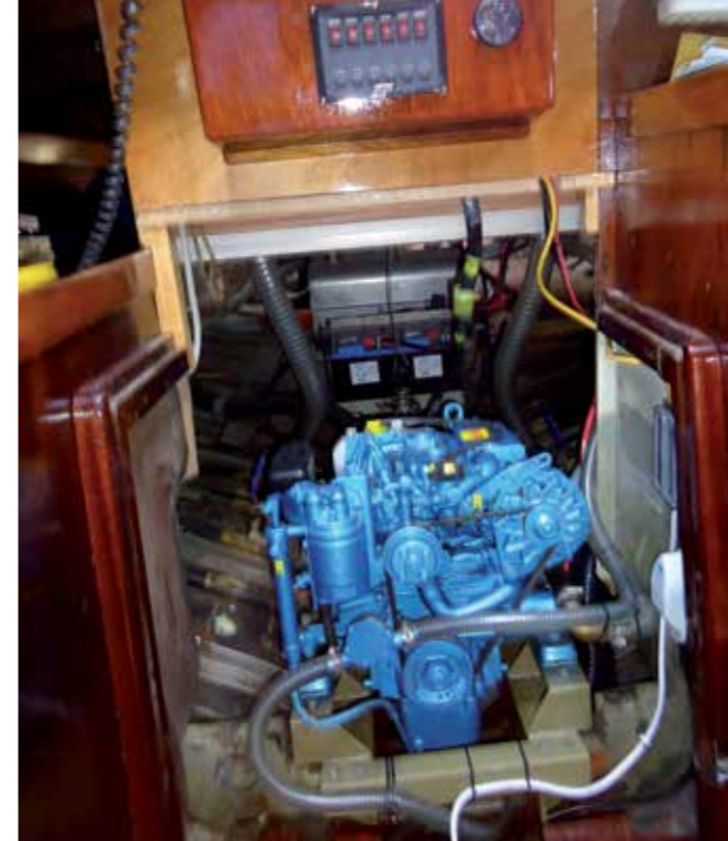
Plaatsen nieuwe motor
