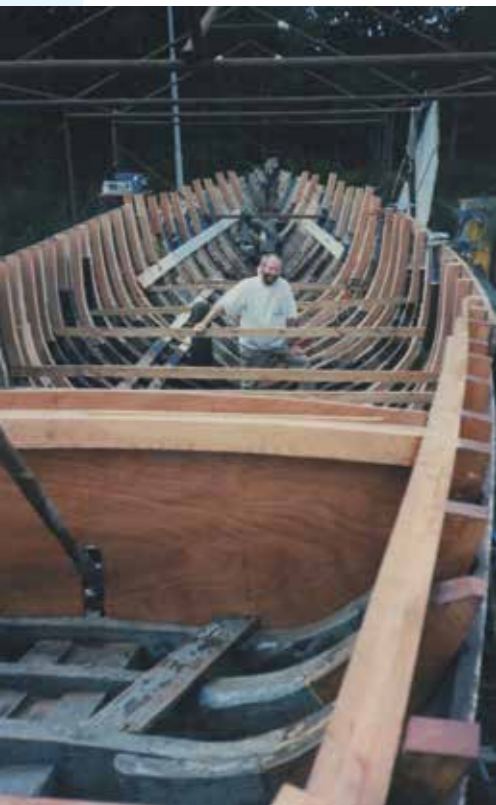
NIEUWE SPANTEN EN DEKBALKEN MAKEN
