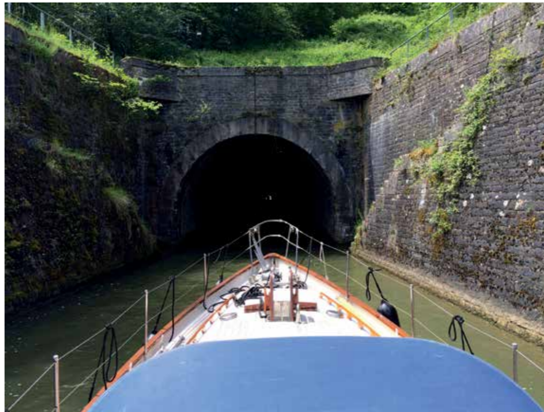
Door de tunnel
