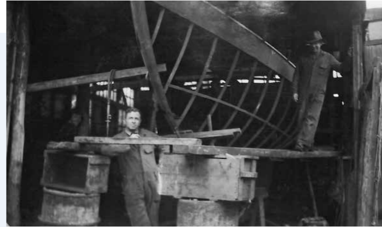
De Dirkje in aanbouw
